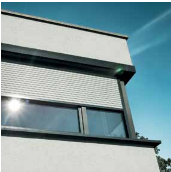
Vorbaurollladen PENTO flächenbündig mit der Fassade montiert.
